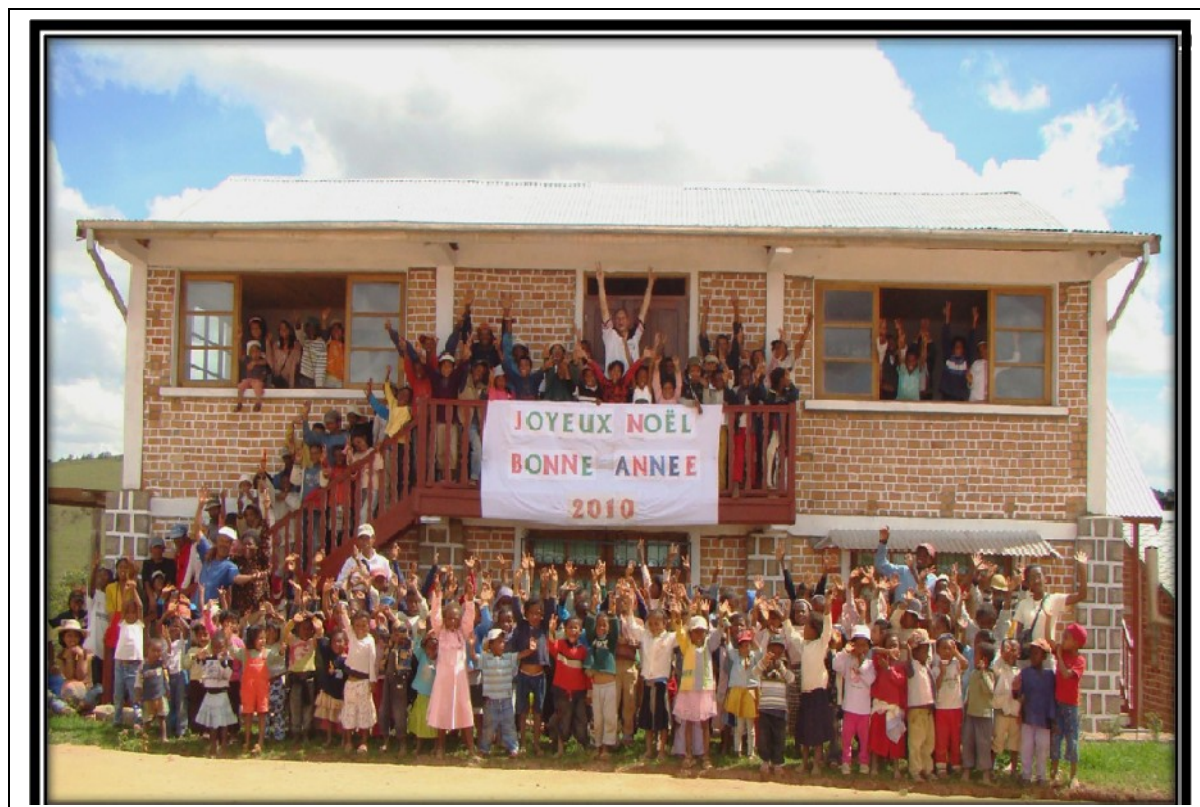
Le 2 e bâtiment scolaire achevé à Talakimaso/Madagascar, lieu d'activité de l'association "la Maison d'Aïna" - Décembre 2009
